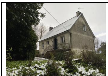
Photo générale de l'immeuble
